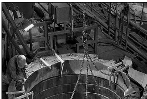
Obrázok 2 Údržba žiaruvzdornej výmurovky
