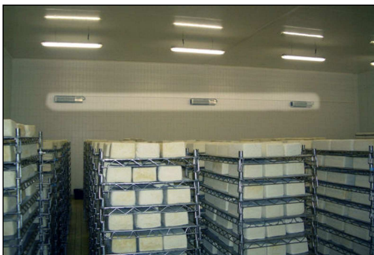
Obrázok 1 Inštalácia nástenných ozonizačných zariadení pre dezinfekciu miestnosti osušovania syrov.
